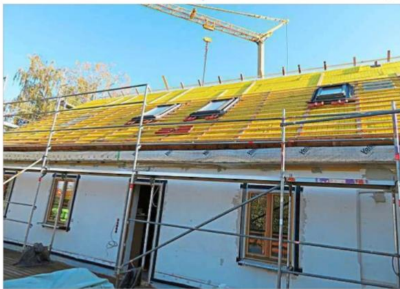
In Niedertaufkirchen sind die Arbeiten voll in Gange. Das Dach des „ConnectionHouse“ wird energetisch saniert und erhält Solarmodule. – Fotos: Jaensch
