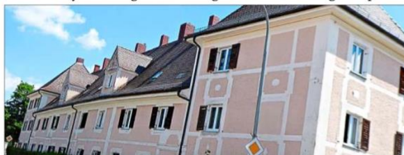
Das Genossenschaftshaus an der Trostberger Straße wurde vergangenes Jahr gekauft. – Foto: Hölzlwimmer
